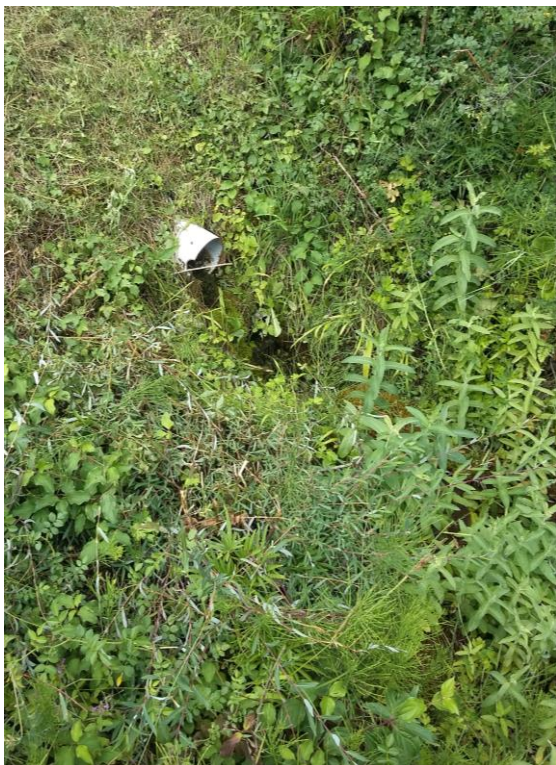
Photo 3 : évacuation du trop-plein dans le talus
